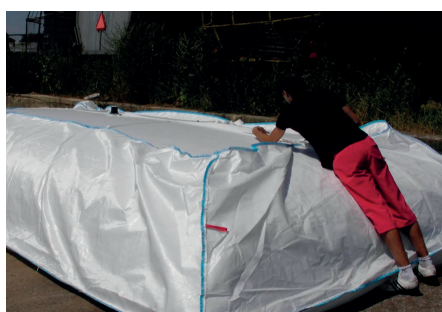
Doťahovanie popruhov záchytnej vane
