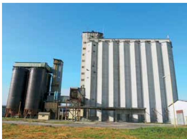
Pohľad od železnice na veľkokapacitné železobetónové obilné silo RWA Podunajské Biskupice (1976 - 1977), vľavo sú v roku 1987 dostavané ocelové zásobníky.
