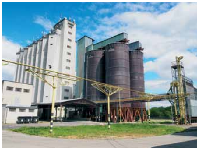
Pohľad na sústavu síl z juhu, v popredí nadzemný plynový potrubný most sušičky uložený na ocelovej konštrukcii.
