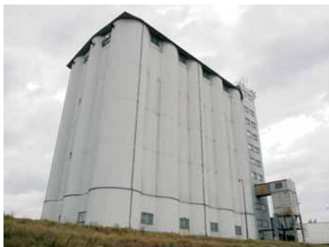
Veľkokapacitné oceľové obilné silo RWA Marcelová, celková kapacita je 20 000 ton.
