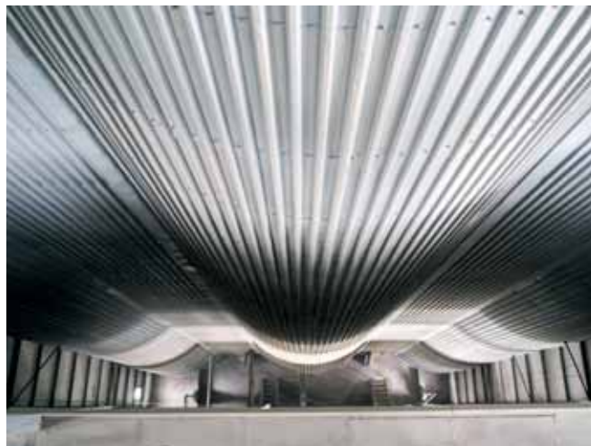
Pohľad dolu na prízemie zo siedmeho poschodia strojovne, oproti plášť silových buniek s povrchom z ocelových nitovaných plechov, ktorý je aj na vonkajších častiach.
