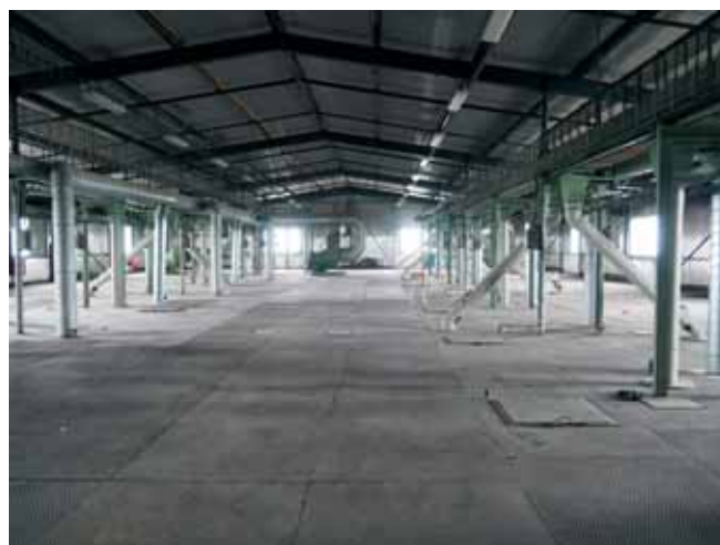
Pohľad na interiér posledného poschodia.
